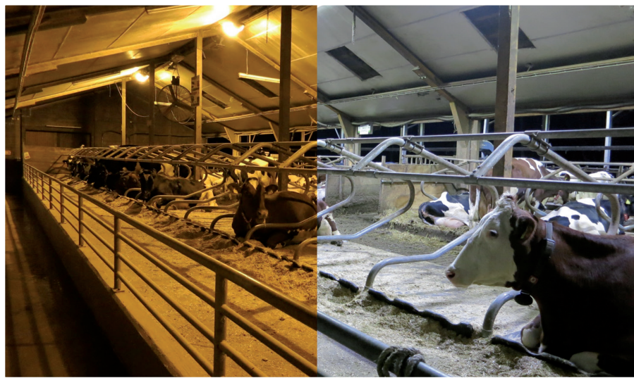
Abb. 3: Versuchsstall mit ursprünglicher Natriumdampfbeleuchtung (links) und neuer LED-Beleuchtung (rechts)
